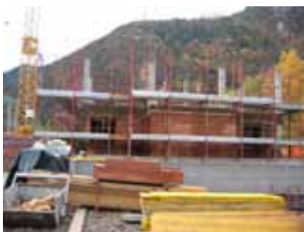
I lavori di costruzione della nuova caserma carabinieri
