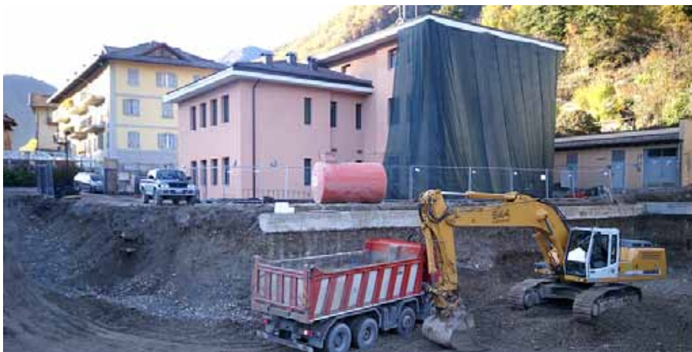
La casa della salute di Bezzecca con i lavori di costruzione del garage interrato per casa di Riposo.
